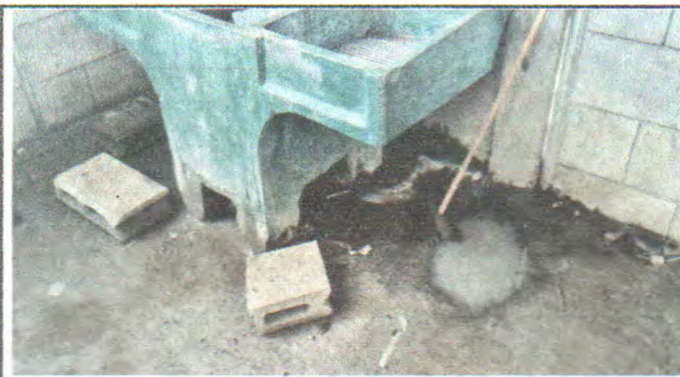
DRENAJE EN LAVANDERIA Y SANITARIO
