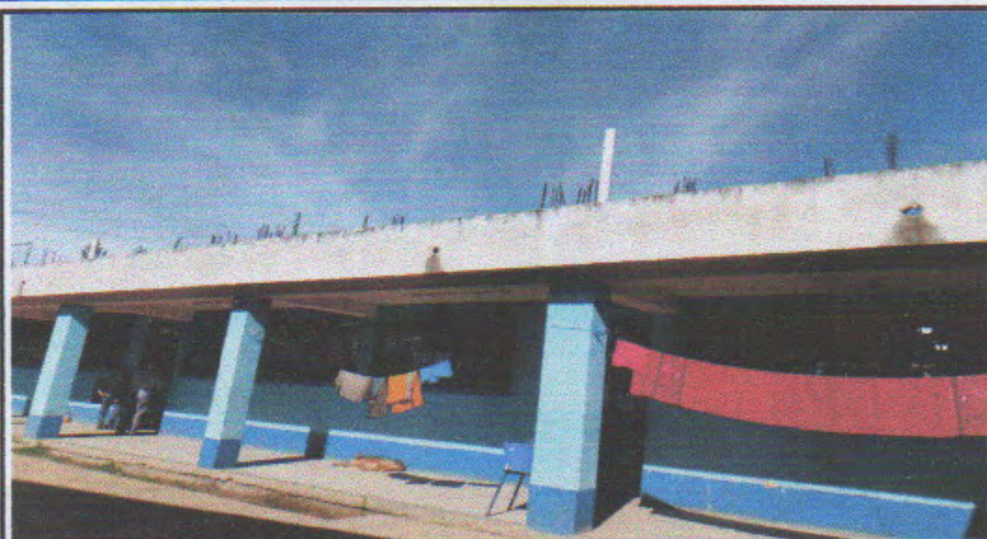
Reparacion de agua pluvial sobre terraza
