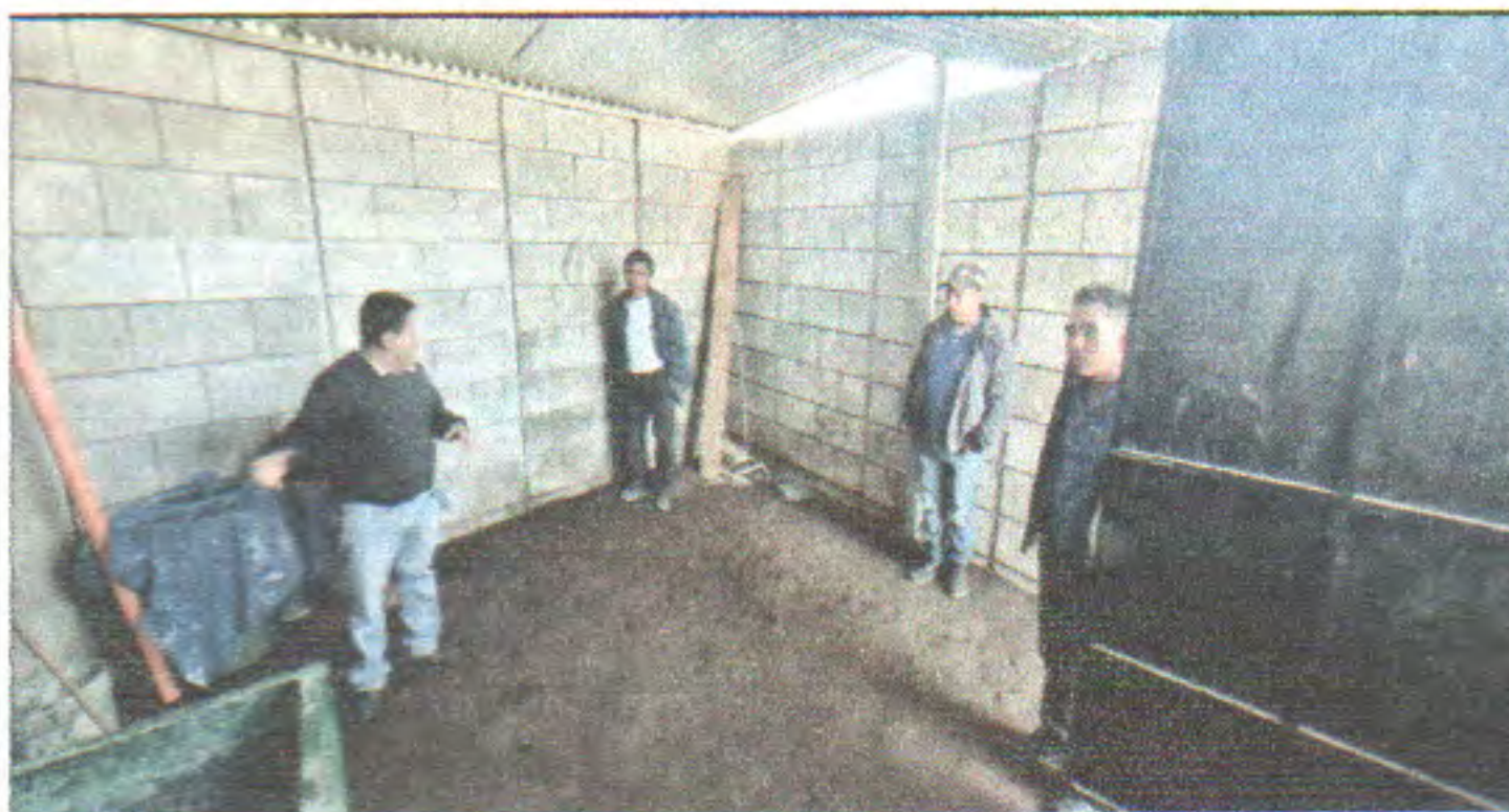
PISO EN LAVANDERIA
