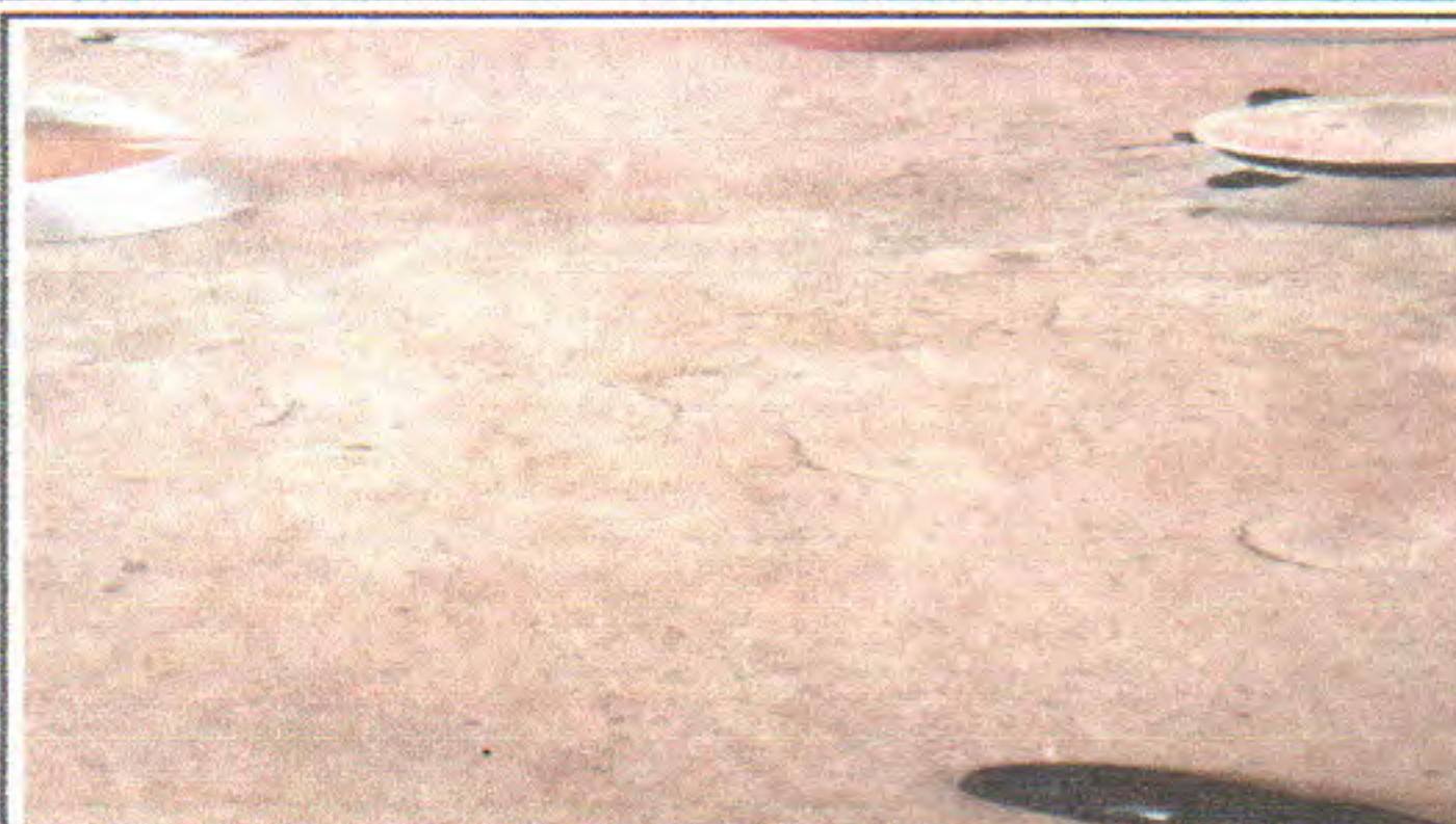
INSTALACION DE PISO EN COCINA
