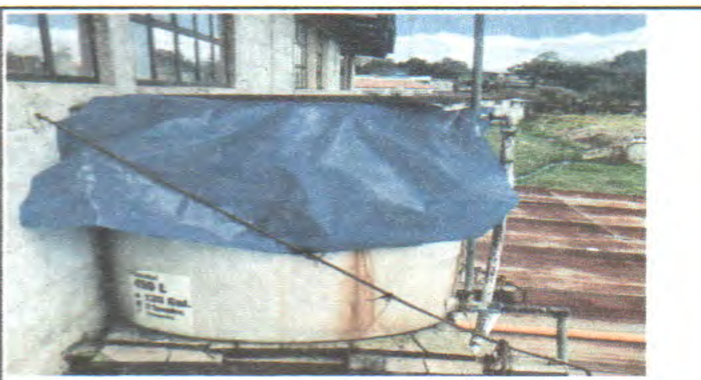
REPARACION Y MANTENIMIENTO CISTERNA(ROTOPLAS)
